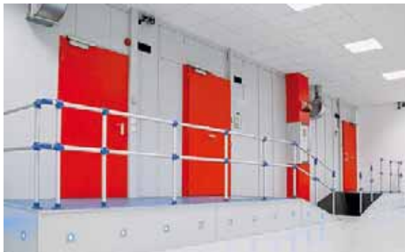
Die Sicherheitstüren zu den einzelnen Bereichen im Vorraum des KAMP-Rechenzentrums Foto: KAMP
